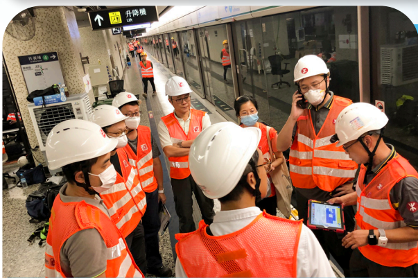
機電署人員在施工當天與港鐵公司人員商討工作進度和細節。
