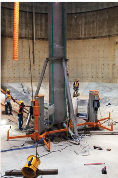
工人在大埔污水處理廠指定污泥消化缸內安裝廚餘共厭氧消化混合器。
