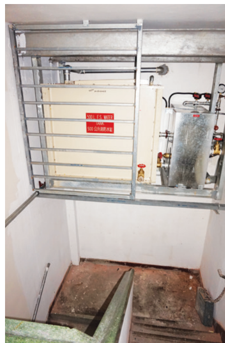
推行第二階段「喉轆系統」計劃後，可在狹小空間安裝消防供水缸。
