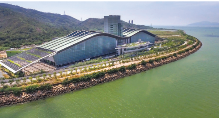
T·PARK [源·區] 結合多項先進技術，包括污泥焚化、發電、海水化淡及污水處理。
