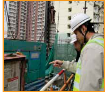
圖五、在惡劣天氣過後為工作場地進行檢查，確保安全後方可復工
