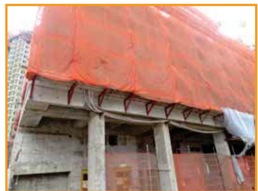
圖一、確保棚架等結構物穩固，一旦風雨來臨也不會塌下或鬆脫
