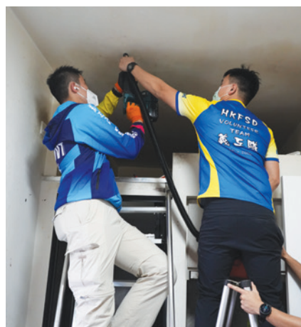
安裝獨立火警偵測器。
