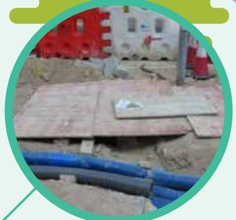
圖三、鬆散物料容易被吹起，在強風情況下必須要將之綁好或移入室內
